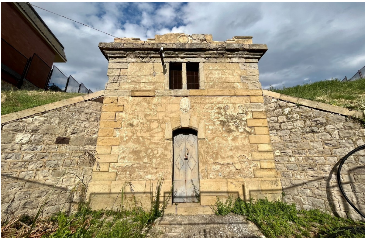
Foto 37. Serbatoio dell'acquedotto dell'Agri
